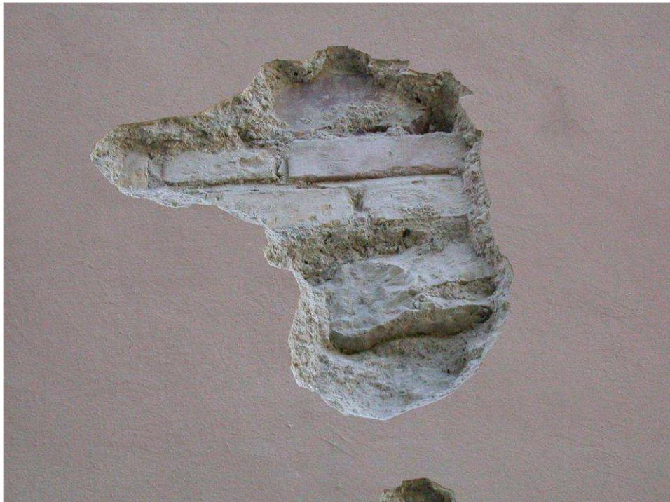
**Foto 06: Saggio muratura piano terra in pietrame con ricorsi in mattoni**
